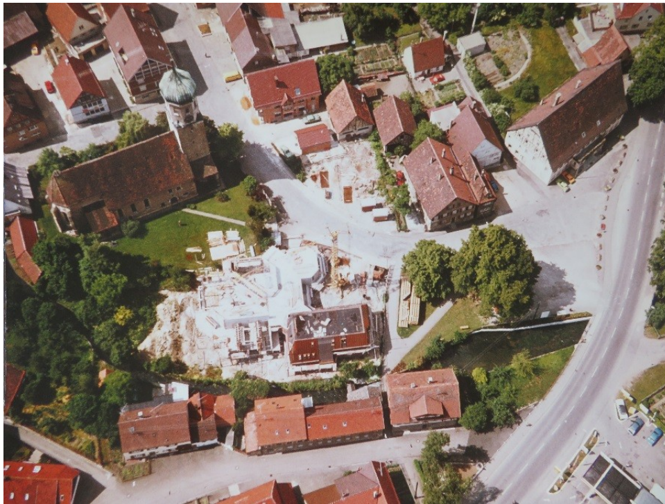
Eine Luftaufnahme aus der Bauzeit: Der Gebäudeteil an der Kanalseite steht bereits. Davor der heutige Spielbereich des Kindergartens (Bild: Stadtarchiv Süßen).
